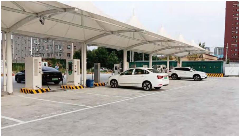
沈阳白塔堡全液冷充电项目
