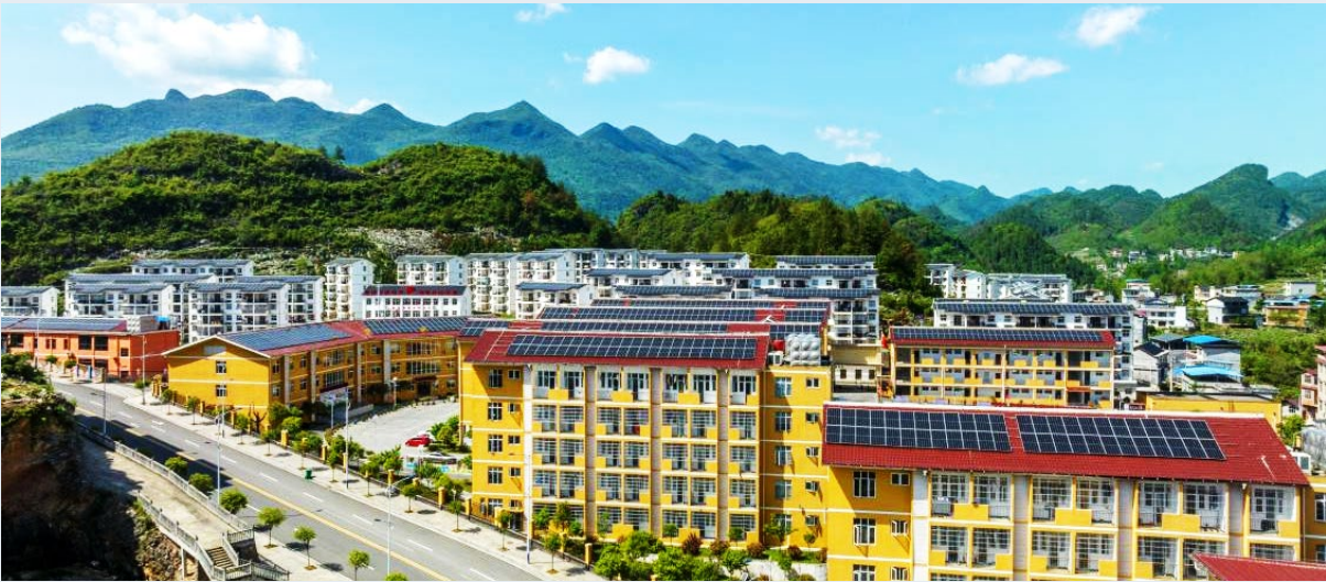
湖北宣恩屋顶光伏项目
