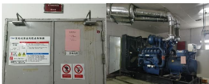
独立的发电机隔音房
