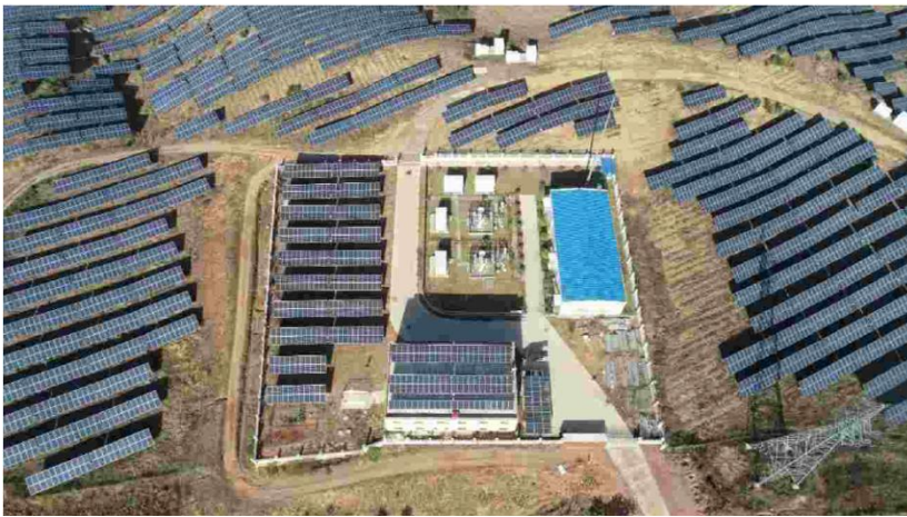
安徽科士达光伏发电项目
