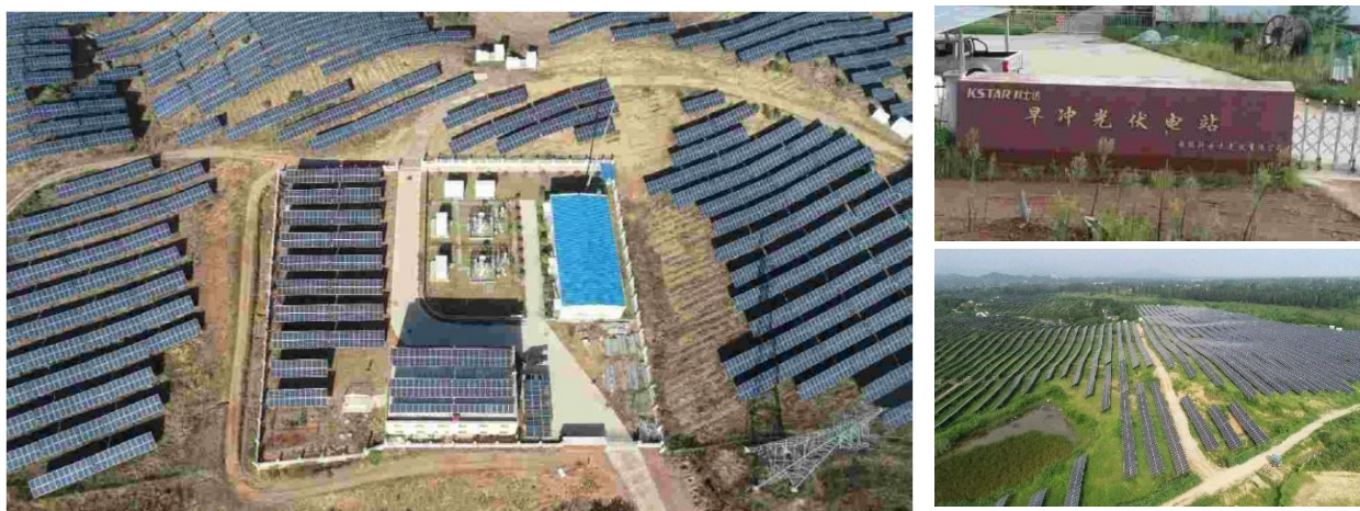
安徽科士达光伏发电项目
