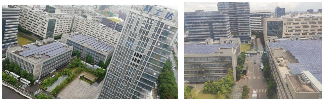
光明科士达工业园楼顶光伏项目
