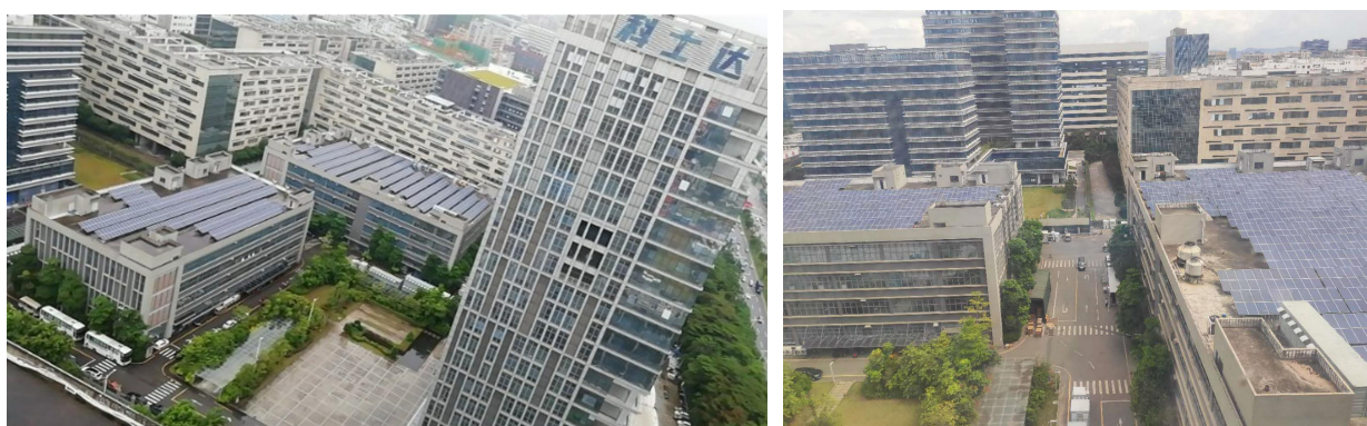
光明科士达工业园楼顶光伏项目
